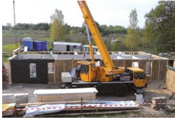
2. Aufstellen der letzten Wand im Erdgeschoss. Befestigungs- und weitere Nebenarbeiten folgen, Regenschutzplanen werden angebracht. Die Decke wird hergestellt, massive Innenwände werden gemauert. Dauer ca. 14 Tage.
