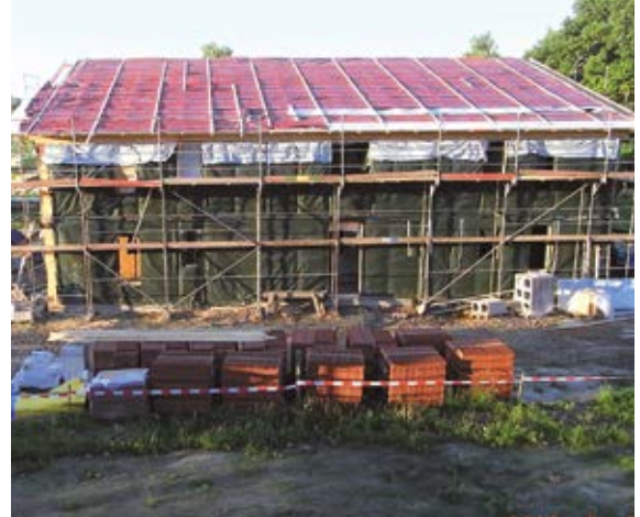
6. Abplanen des Daches. Weitere Arbeiten im Inneren für ca. 14 Tage.
