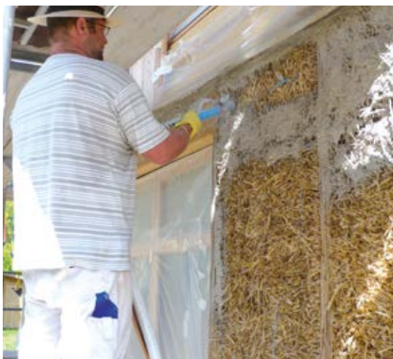
1. Erste Lage Luftkalkputz außen. Holzteile hier mit Putzträger aus Schilfrohr belegt.
