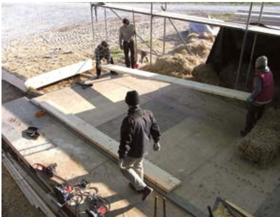
1. Montageteich unter einem provisorischen Vorfertigungsdach neben der Baustelle. Die ersten Holzteile einer ca. 2,8 m x 4 m großen Wand werden ausgelegt: unteres Rahmenholz, Schwelle und oberes Rahmenholz.
