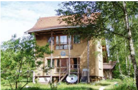
Villa Strohbunt (Sieben Linden): Handbaustelle – errichtet ohne Strom 2001–2003
