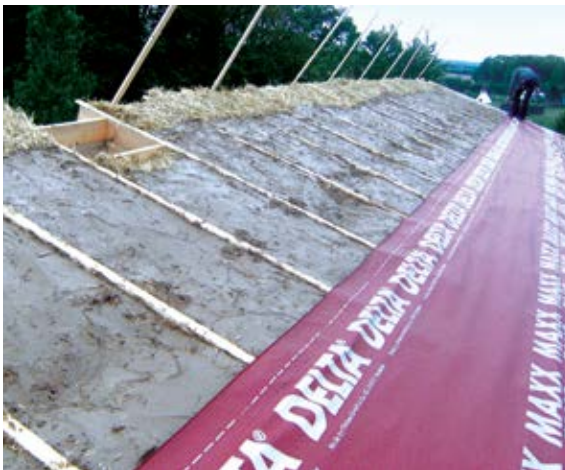
5. Dachstrohballe mit Lehmputzlage und Unterspannbahn.
