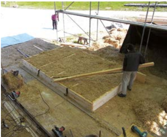
13. Einbau der oberen Klemmleisten.
