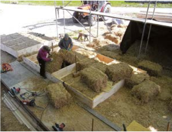
7. Einbau des ersten Endballens: Die notwendige Vorkomprimierung wird durch verkipptes Eindrücken überlanger Ballen erreicht.
