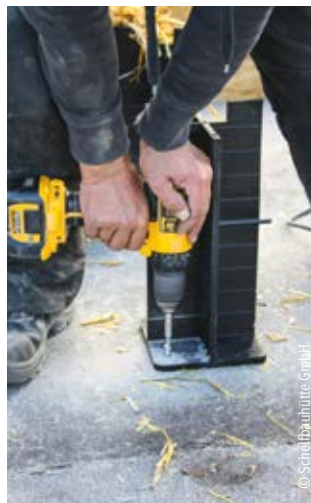
Der von der Schelfbauhütte entwickelte Kunststoffhalter
