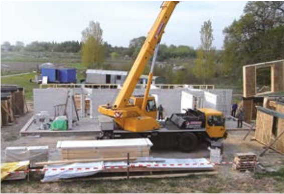
1. Aufstellen der ersten Wand im Erdgeschoss.
