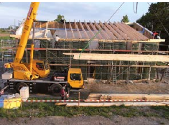
1. Auflegen von Sparren (ohne Element-Vorfertigung).
