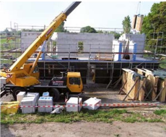
3. Aufstellen der ersten Wand im Obergeschoss.
