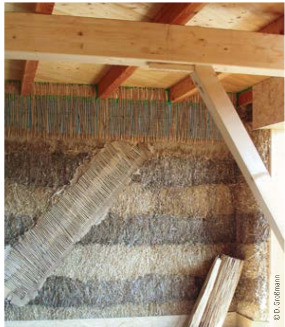
Strohwand mit Schilfrohr als Putzträger und blau durchscheinender Luftdichtungsbahn im Deckenanschlussbereich
