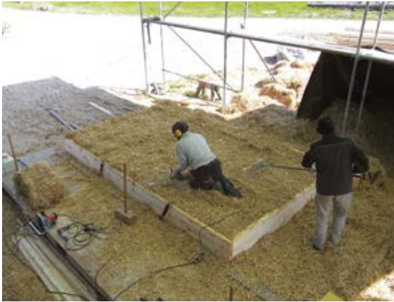
11. Nachrasieren der Oberfläche mit Heckenschere oder Elektrokettensäge.
