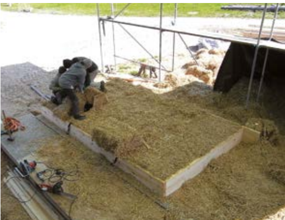
9. Abschluss des Balleneinbaus.
