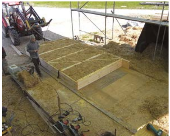
14. Fertiges Wandteil. Herstellungsdauer ca. 4 Stunden.
