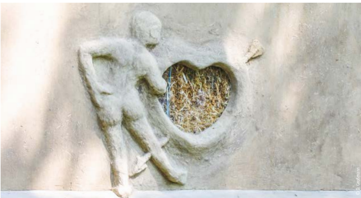
Ein sogenanntes „Truth Window“ zeigt die Strohdämmung.
