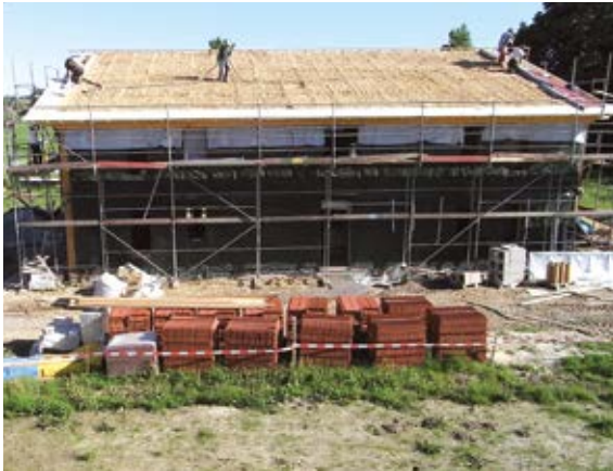
3. Abschluss des Balleneinbaus.
