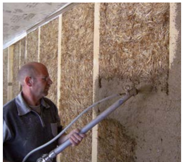
2. Auftrag der ersten Lage Lehmputz innen. Das Aufbringen mittels Putzmaschine hat sich bewährt, ist jedoch auch von Hand möglich.
