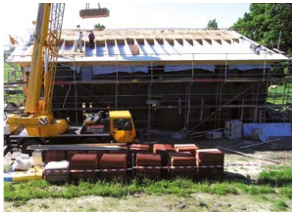
2. Einbau der Ballen zwischen die Sparren, die unterseitig eine Schalung und eine Luftdichtung erhalten haben.
