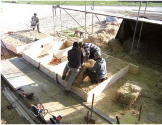
5. Eindrücken eines Endballens mittels Körpergewicht und Gleitplatten durch zwei bis drei Personen. Die Längskomprimierung beträgt ca. 10 %.
